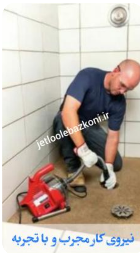
بازکردن تمامی لوله های منزل
